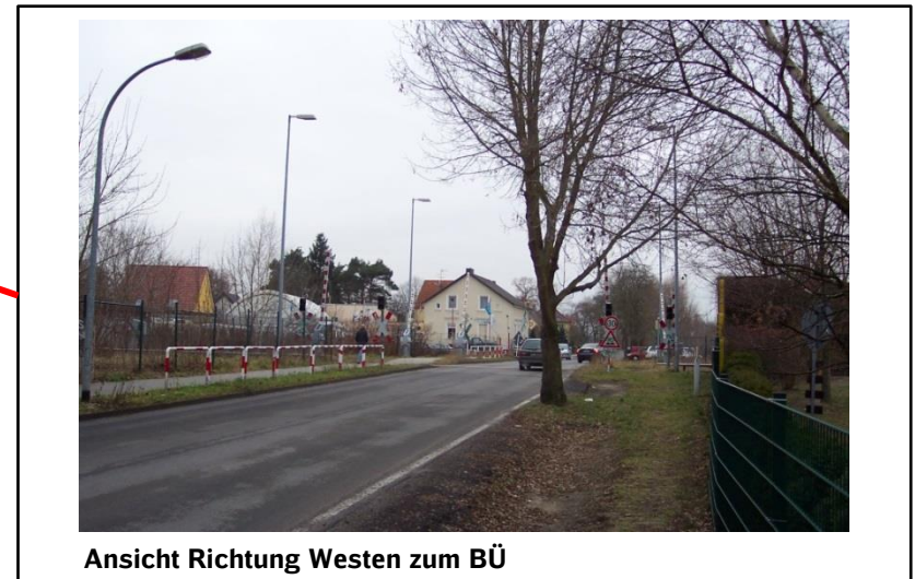
Ansicht BÜ von der Zufahrt Unterwerk Westseite
